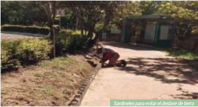
Sardineles para evitar el deslave de tierra
