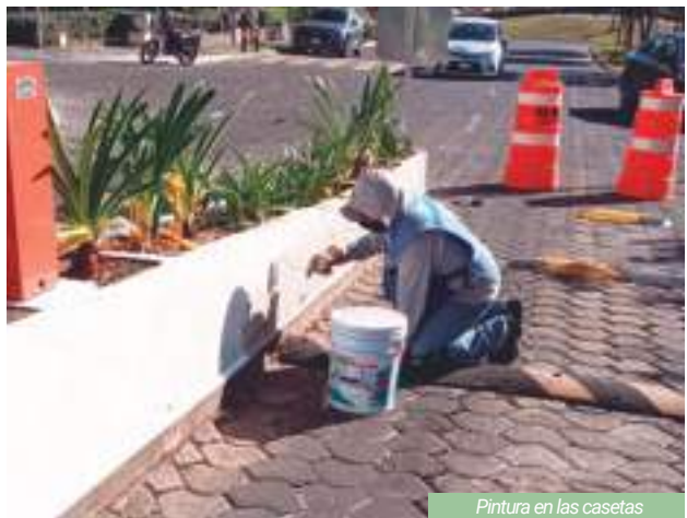
Pintura en las casetas
