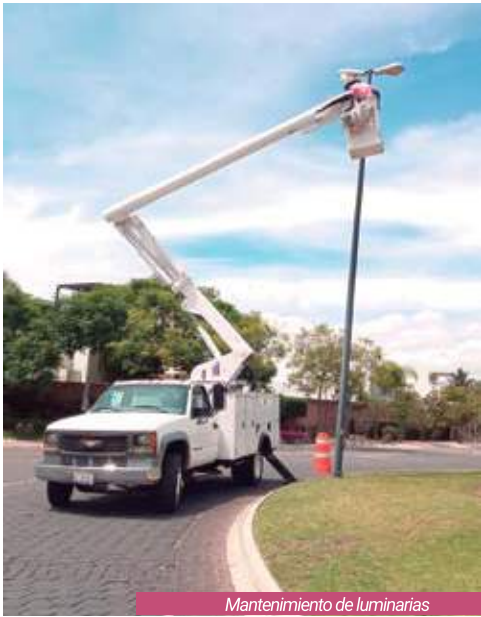
Mantenimiento de luminarias
