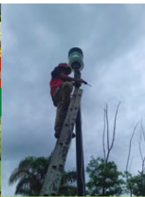
Cambio de luminarias
