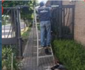
Cambio de contrapuerta
