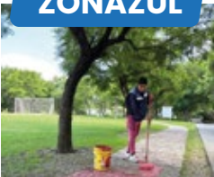
Aplicación de impermeabilizante
