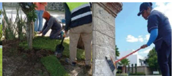
Mantenimiento a caseta de seguridad
