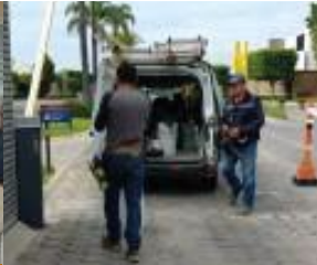
Reparación de barreras
