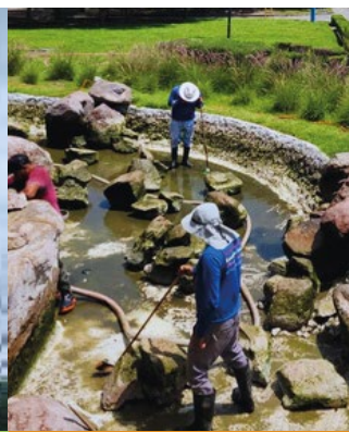
Limpieza de cascadas
