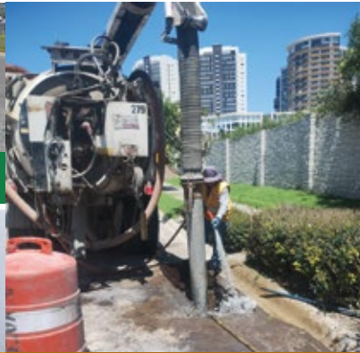
Desazolves en vialidades.
