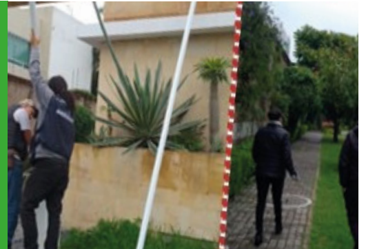
Reparación de Barrera vehicular
