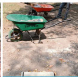
Elaboración de registro con tapa para instalaciones eléctricas subterráneas para evitar cortos circuitos.
