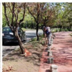
Colocación de adoquín modelo de tulipán gris en perímetros de andador de Gran Boulevard Lomas.
