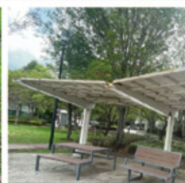
Lijado de pérgolas de Parque de los Deportes
