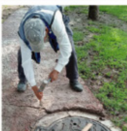
Trabajos de reparación de andadores de Parque de los Deportes
