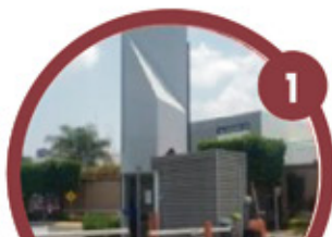
Supervisión de seguridad
