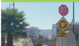
Instalación de señalética
