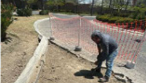
Colocación de adoquín
