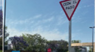
Colocación de señalética vertical
