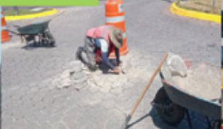
Colocación de adoquín
