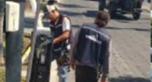
Reparación de barrera
