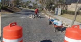
Colocación de adoquín
