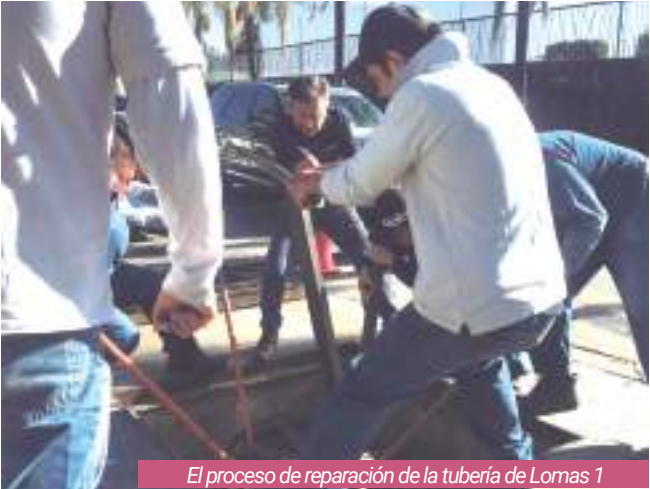
El proceso de reparación de la tubería de Lomas 1
