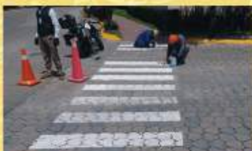
Aplicación de pintura de tráfico
