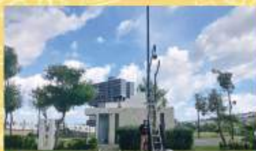
Instalación de cámaras en Avenida del valle
