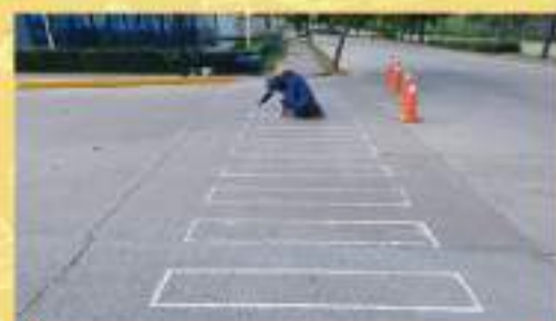
Aplicación de pintura de tráfico
