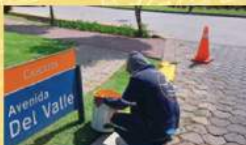
Aplicación de pintura de tráfico para la demarcación de guarniciones
