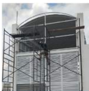
Instalaciones de la Planta de tratamiento
