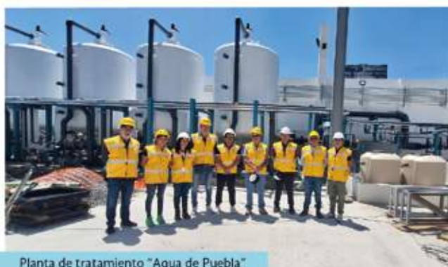
Planta de tratamiento "Agua de Puebla"
