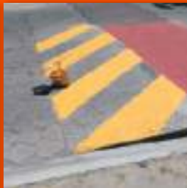
Reparación y pintura de topes .
