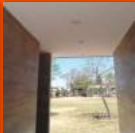
Pintura y reparación de baños en parques.
