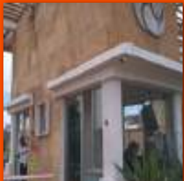
Reparación y pintura por daños a las casetas monumetales.
