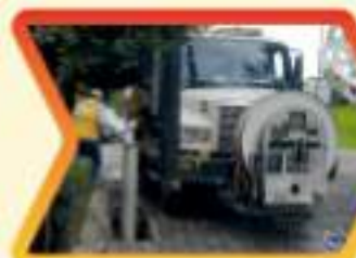
Atendimos junto con Agua de Puebla, la primera etapa de desecho de alcantarillas dentro del macro condominio.
