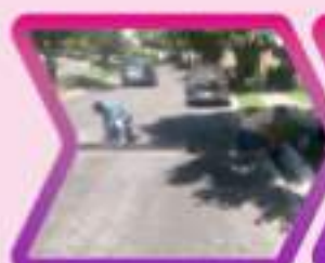
Se realiza reparación de rejilla pluvial en Gran Boulevard Lomas.
