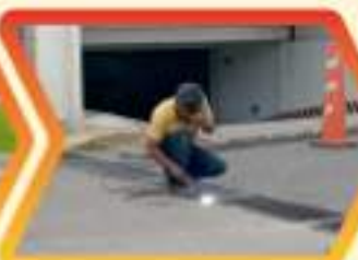
Reforzamos la rejilla del Acceso Norte.
