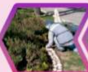
Recuperación del camellón de entrada en Blvd. Europa, jardinería, retiro, cambio de señalética, mayor iluminación, colocación y delimitación de vallas.
