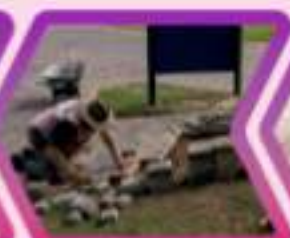
Se crea camino de adoquín para cruce peatonal en camellón de Boulevard Europa.
