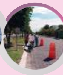
Limpieza de trampas y canaletas pluviales en vialidades.
