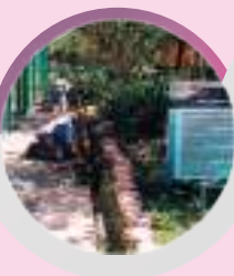
Colocación de adoquines para sardinel en andador de perímetro de canchas de pádel en Parque Central.
