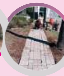
Colocación de adoquines en camellón central de Boulevard Europa.
