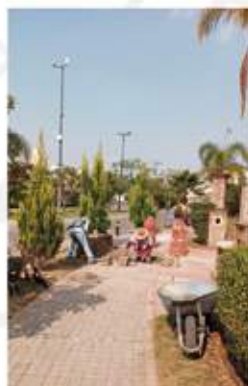
Reacomodo de adoquines en blvd. Asia
