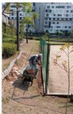
Canaleta en perímetro de cancha de arenas
