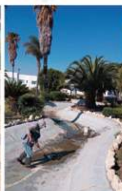
Mantenimiento a membrana del lago
