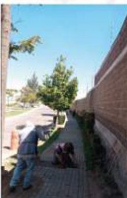
Reacomodo de adoquines
